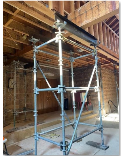
Shoring in Westminster Commons
